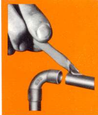
Fig. nr.4 Ungerea cu pastă decapantă
